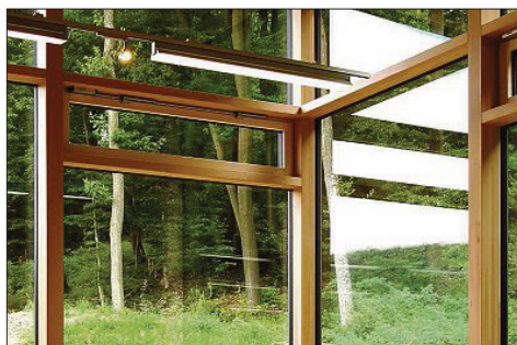
Die Buchen-Pfosten-Riegel-Fassade.
