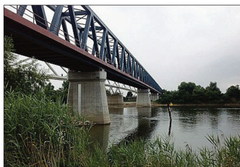
Neubau der Deggendorfer Donau-Eisenbahnbrücke.
