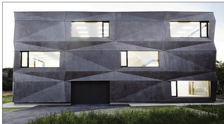
Der Neubau ist ein anthrazit eingefärbter Betonbau.
