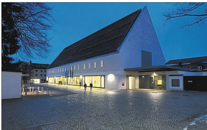
Das neue Kulturzentrum bei Nacht.
