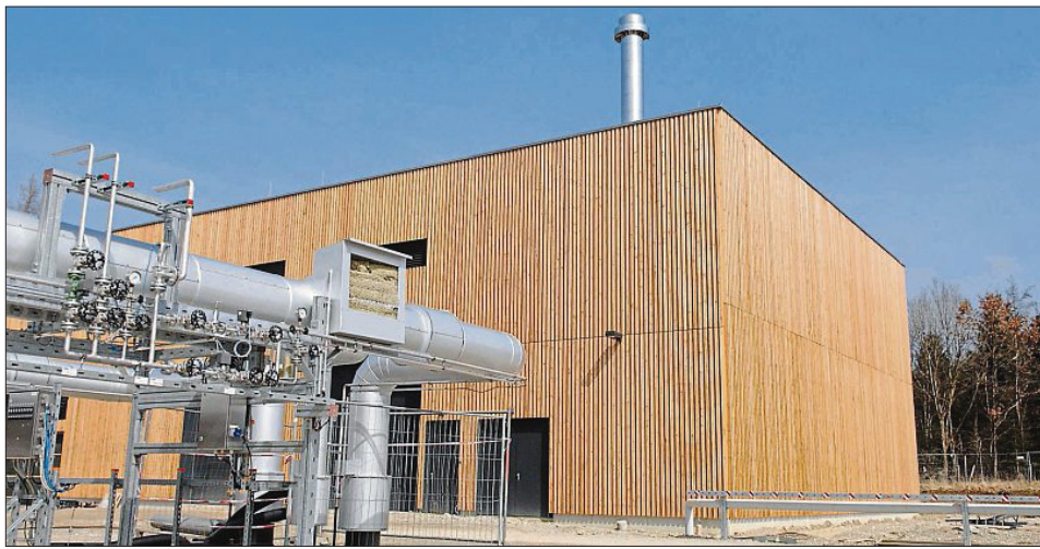
Außenansicht des Heizwerks.
