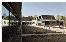
Die Werkstätten. FOTO BIII ARCHITECTEN
