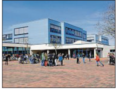
Das generalsanierte Schulzentrum des DZG und der JWR.
