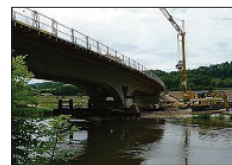
Eine der beiden neuen Brücken.
