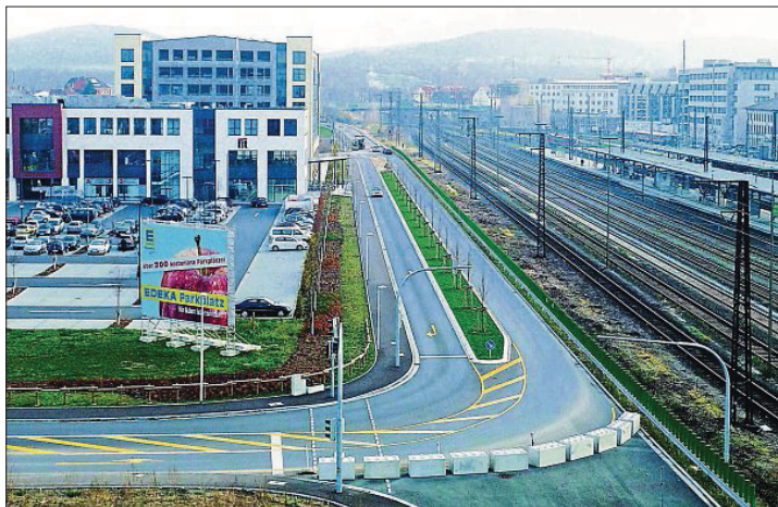
Der Nordring ist noch im Bau.
