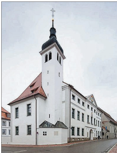
Nordansicht des Gebäudeensembles.
