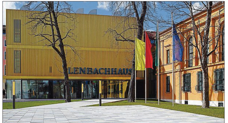
Neubau und Altbestand des Lenbachhauses.
