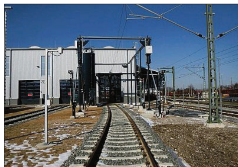
Die Halle von außen mit Sicht auf Gleis 29.
