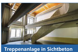
Treppenanlage in Sichtbeton
