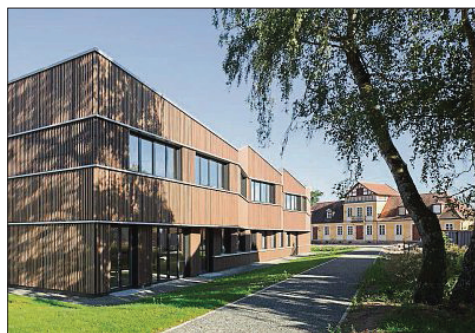
Der Neubau des Fakultätsgebäudes für Landwirtschaft und Umweltsicherung in Triesdorf.
