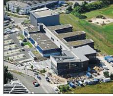
Der Neubau in Fürth-Atzenhof.
