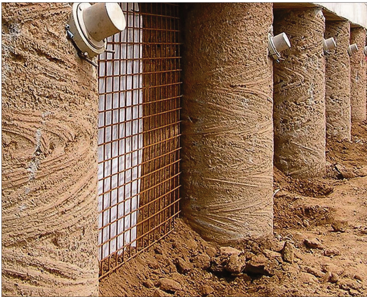
Das Errichten einer Bohrpfehlwand sorgte für juristische Auseinandersetzungen.
