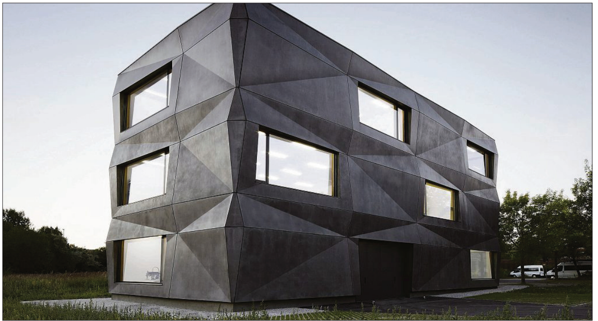
Dieses Produktions- und Bürogebäude steht im Münchner Norden.
