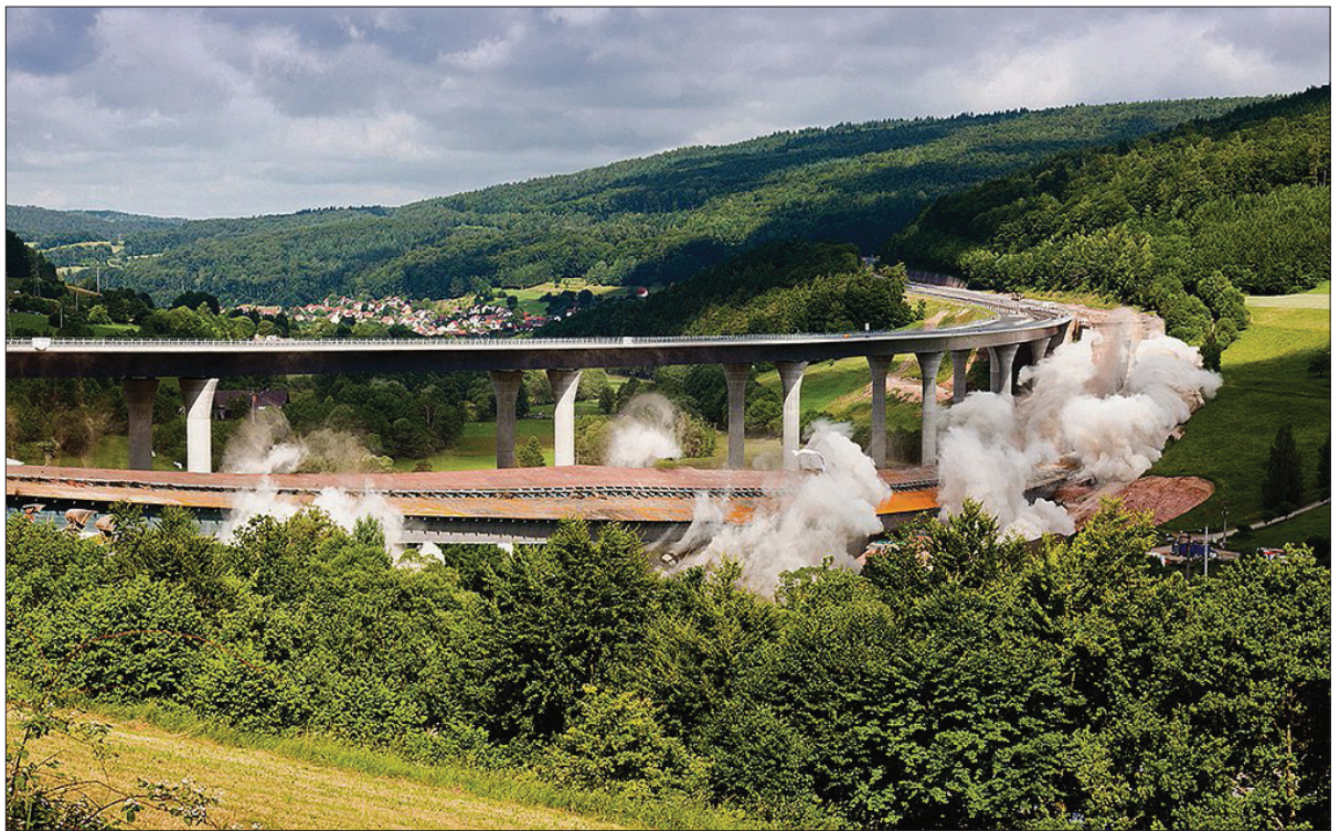
Erneuerung der Sinnthalbrücke an der Autobahn A 3.
