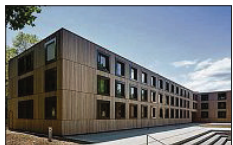
Nordfassade des Unterkunftsgesamtes. FOTO STBA WEILHEIM
