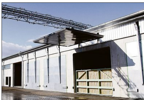
Die BEKON-Biogasanlage in München.
