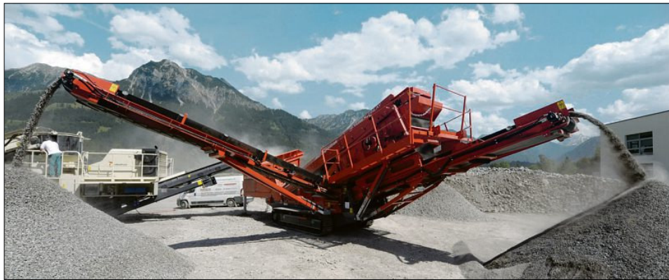
Hier entstehen Recyclingbaustoffe.
