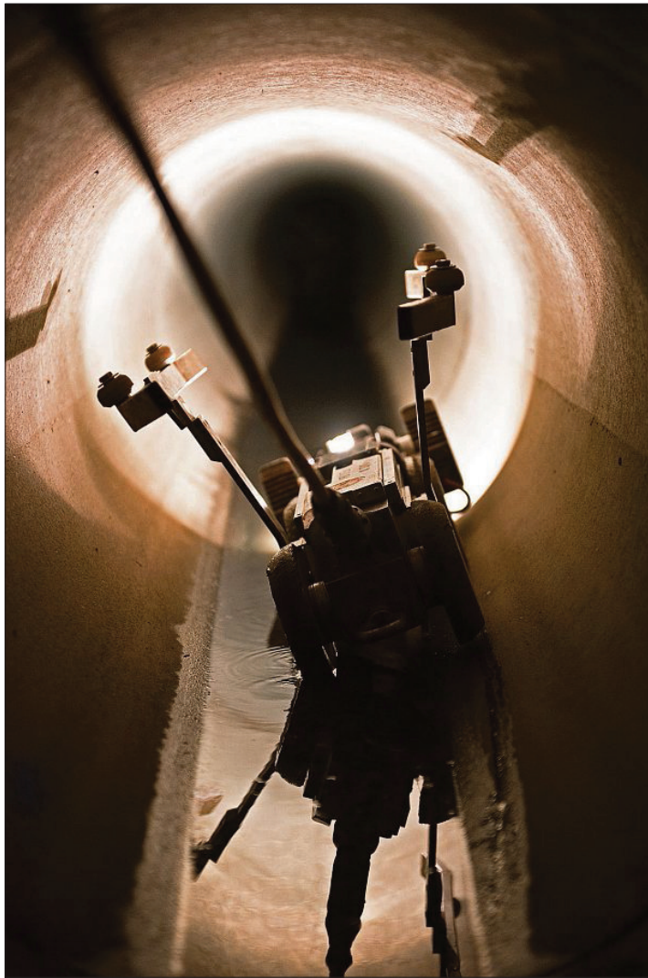
TV-Inspektionen sind eine wichtige Voraussetzung zur Beurteilung des Zustands der Kanalisation. FOTOTRANS-PONDER
