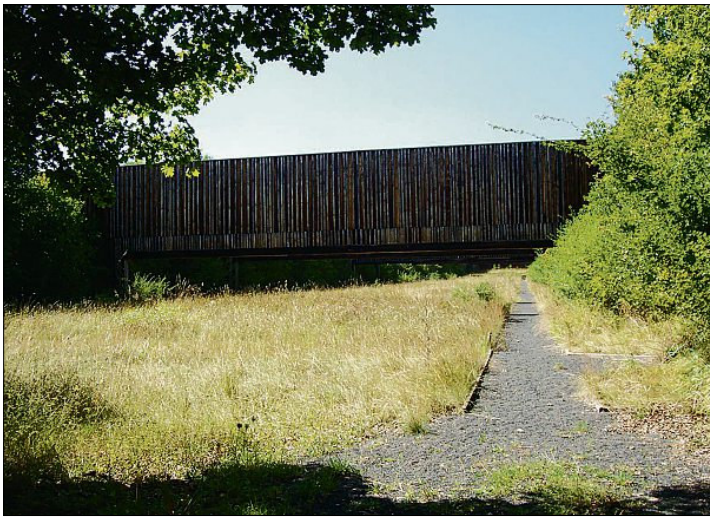
Die Anlage umfasst zirka 14 000 Quadratmeter und liegt in ländlichem, strukturschwachem Gebiet im Naturpark Bayerische Rhön. FOTO RUPP
