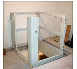
In drei bis fünf Tagen ist der Aufzug fertig montiert.
