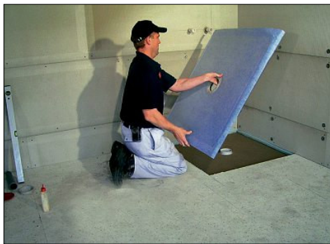
Die Verarbeitung gestaltet sich unkompliziert, denn die umlaufend überlappende Abdichtfolie bietet eine wasserdichte und einfache Anbindung an die Wand. Innerhalb eines Tages sind sowohl der Einbau als auch das Verfliesen abgeschlossen.
