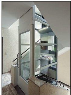
Bei diesem Lift gibt es statt einer Kabine eine Plattform. FOTO:RIEDEL
