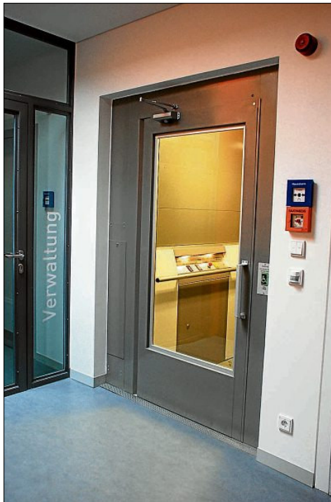
Der nachträgliche Einbau eines Aufzugs ist oft ohne großen Aufwand realisierbar. FOTO RIEDL
