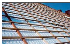
Die Ein-Mann-Schnellverlegeplatte ist gleichzeitig als Behelfsdeckung einsetzbar. FOTO BSZ
