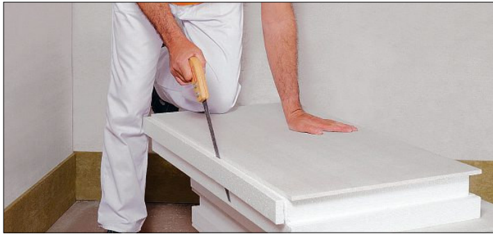
Durch den Einsatz dieser leicht zuschneidbaren Dämmelemente konnte der Wärmebedarf für den Wohnblock aus den 60er Jahren deutlich reduziert werden. FOTOS BSZ
