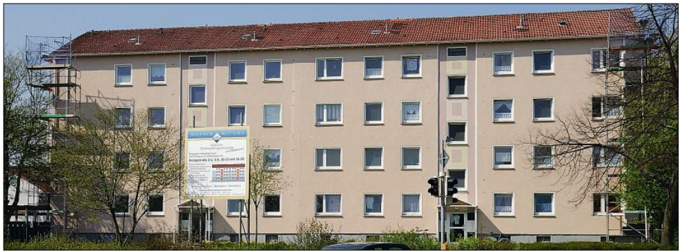
Durch den Einsatz dieser leicht zuschneidbaren Dämmelemente konnte der Wärmebedarf für den Wohnblock aus den 60er Jahren deutlich reduziert werden. FOTOS BSZ
