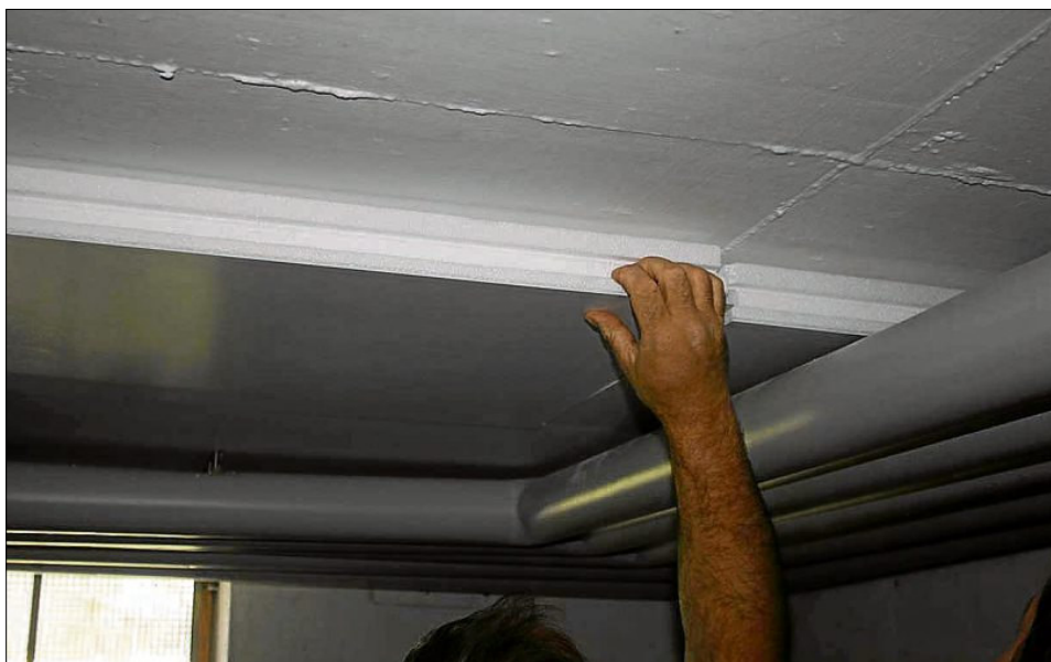
Eine Kellerdeckendämmung mit Styroporplatten.
