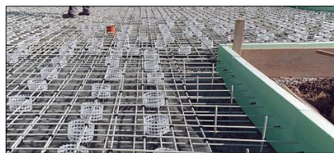
Bewehrung aus Glasfaser.
