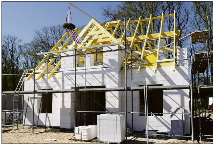
Beim Baustoff Porenbeton ist die Dämmung in Form von Millionen Luftporen gleich mit eingebaut. Da er zudem frei ist von Schadstoffen und entsprechend langlebig, ist er eine wichtige Komponente für nachhaltiges Bauen.
