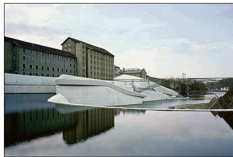
Das Iller-Wasserkraftwerk in Kempten. FOTO BSZ
