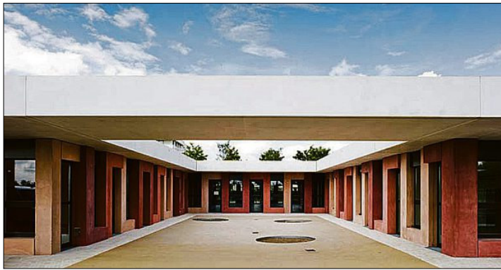
In 20 Jahren soll die Schule anders genutzt werden: Volle Flexibilität erreicht dieser Betonbau. FOTO MICHAEL HEINRICH
