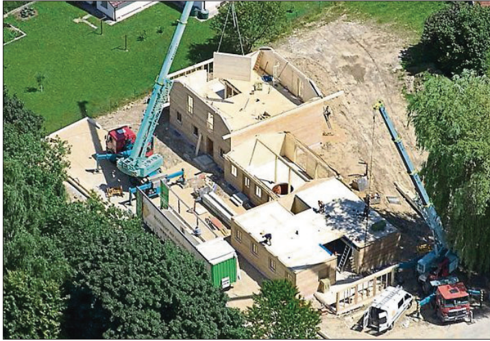
Der Aufbau eines Holzhauses aus der Luft gesehen.
