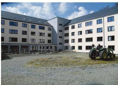
Altenheim in Libramont / Belgien 4-Geschosser und Dach in Brettsperrholzbauweise
