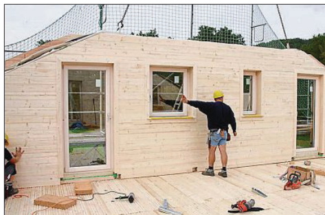
Beim klassischen Holzfertigbau dominiert die Verbundbauweise.
