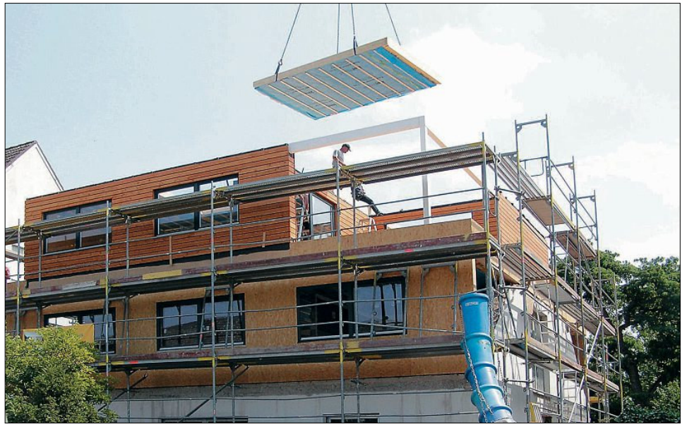
Durch Vorfertigung bei Dach- und Deckenelementen kann der Innenausbau schon nach rund drei Tagen beginnen.
