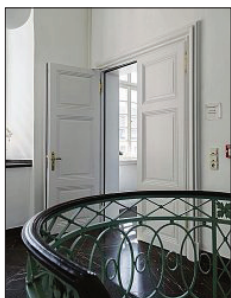
80 Brandschutztüren mussten eingebaut werden. FOTO BZ
