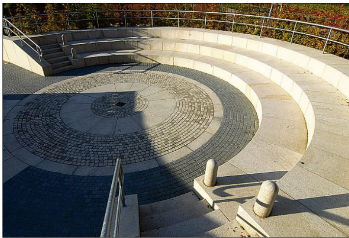
In die Planung des Amphitheaters für die Regionalschule Bergen flossen auch die Wünsche und speziellen Bedürfnisse der Schüler ein. Das neu entstandene Areal wird zudem als öffentlicher Spielplatz genutzt
