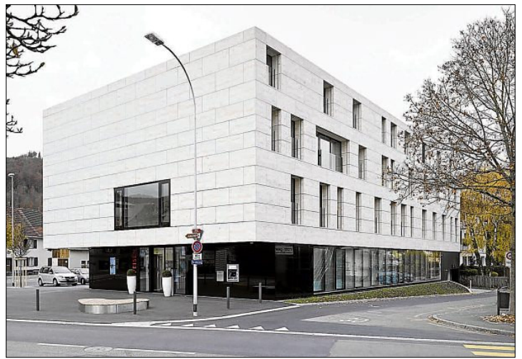
Der Neubau der Raiffeisenbank Aare-Rhein.
