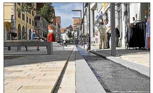
Wasserrinnen aus dunkelgrauem Granit verlaufen längs durch die Innenstadt und verleihen der Fußgängerzone eine Dynamik. FOTOS BESCO
