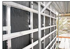
Die Aluminium-Unterkonstruktion.
