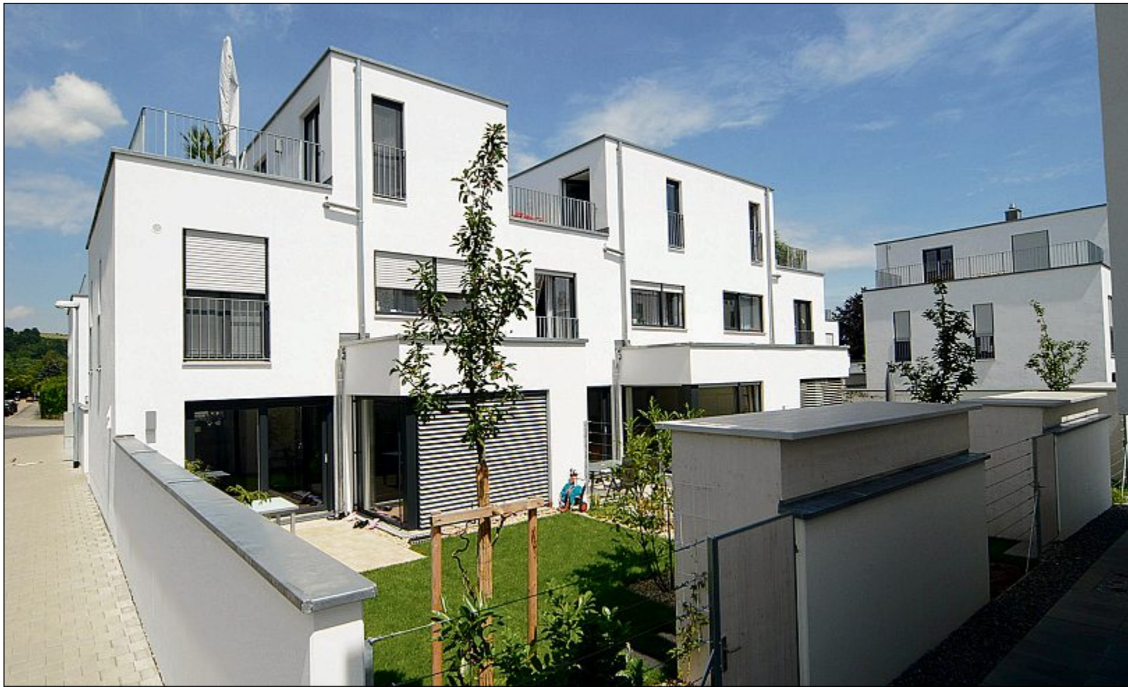
Eine Wohnanlage gebaut mit perlitgefüllten Ziegeln.
