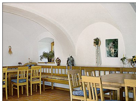
Wände vor und nach dem Einsatz von Hydroment-Putzen. FOTOS HYDROMENT
