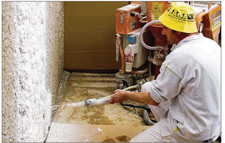
Aufbringen des ökologischen Isolierputzes.
