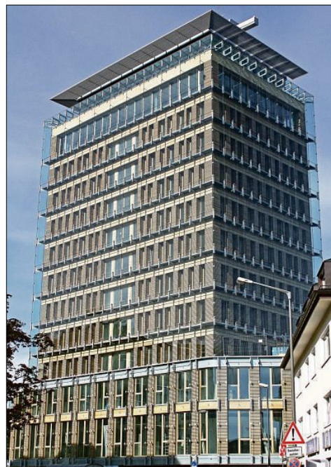
Das sanierte Sparkassenhochhaus in Rosenheim.
