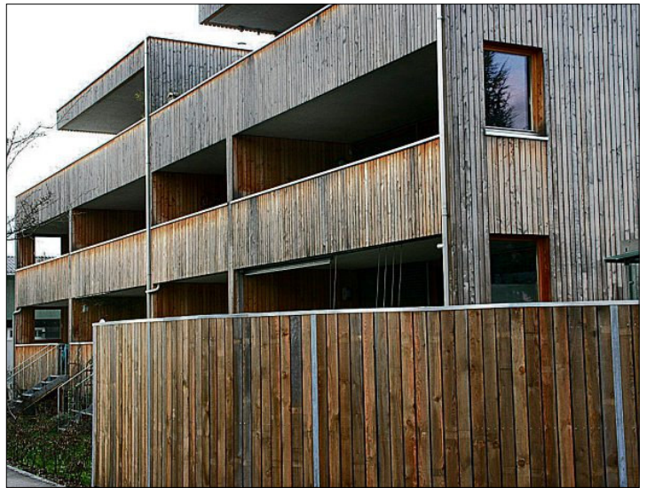
Mit Holz liegt man bei der Fassadensanierung goldrichtig.
