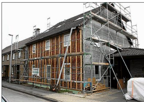
Die Hausfassade vor dem Anbringen der Vollschutzfassade ...
