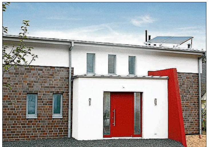
Energetisch auf Top-Niveau: Dank sehr guter Wärmedämmung und einer sparsamen Öl-Brennwertheizung mit Solarthermie werden in dem neu errichteten Einfamilienhaus in Buchholz/Nordheide weniger als zwei Liter Heizöl pro Jahr und Quadratmeter benötigt.
