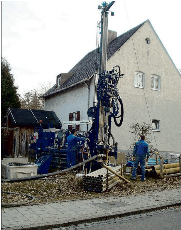
Drei bis vier Erdwärmesonden pro Einfamilienhaus genügen.
