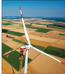
Der Bürgerwindpark von Berching ist ein Vorzeigeprojekt finanzieller Bürgerbeteiligung. FOTO BSZ
