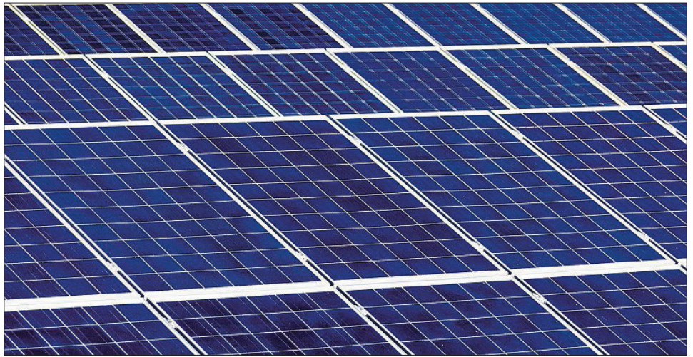
Derzeit gibt es viel Streit um den weiteren Ausbau von Photovoltaik-Anlagen.
