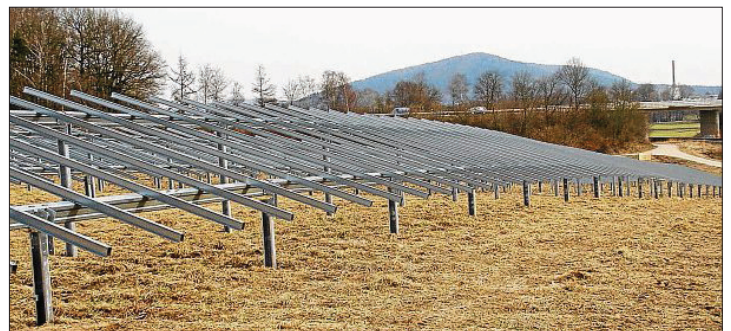
Baubeginn des Solarparks Neustadt-Bahn.
