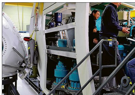
An Originalteilen der Windenergieanlagen wird nicht nur alles genau erklärt, die Arbeiten können auch praktisch geübt werden. FOTO GE
