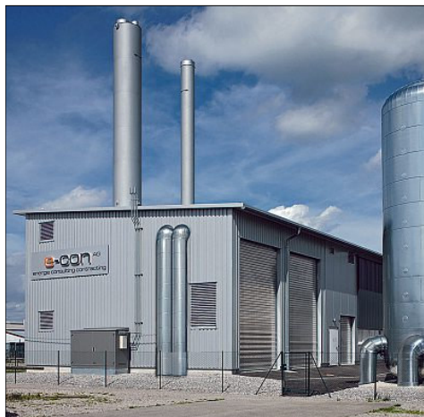
In Memmingen sorgt dieses Heizwerk für Wärme in Unternehmen wie Dachser, Goldhofer und Pfeifer. FOTO: BSZ
