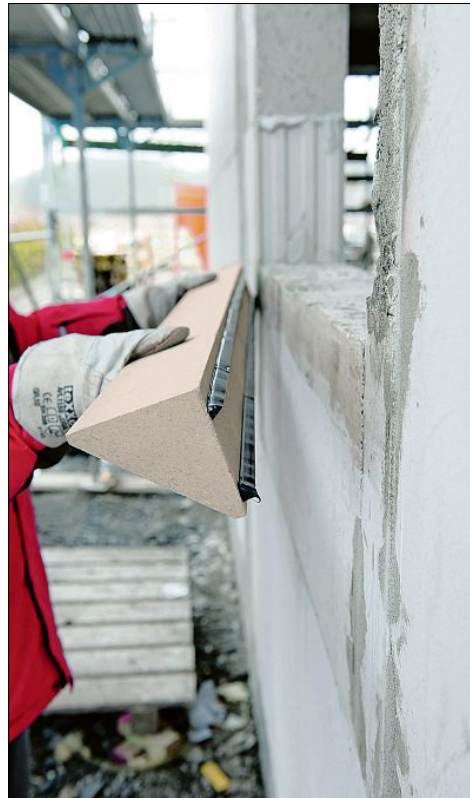
Das Vorwandmontagesystem ist nur geklebt.
