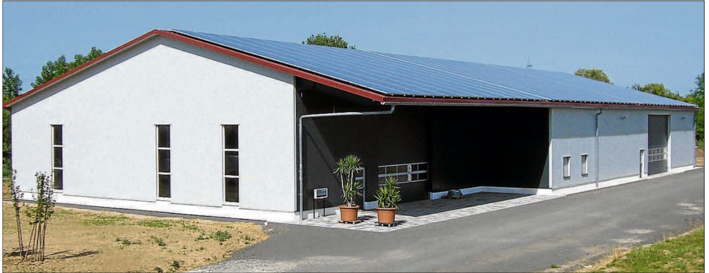
Durch eine innovative Rahmenkonstruktion wird in der Halle eine größere Traufenhöhe erzielt.
