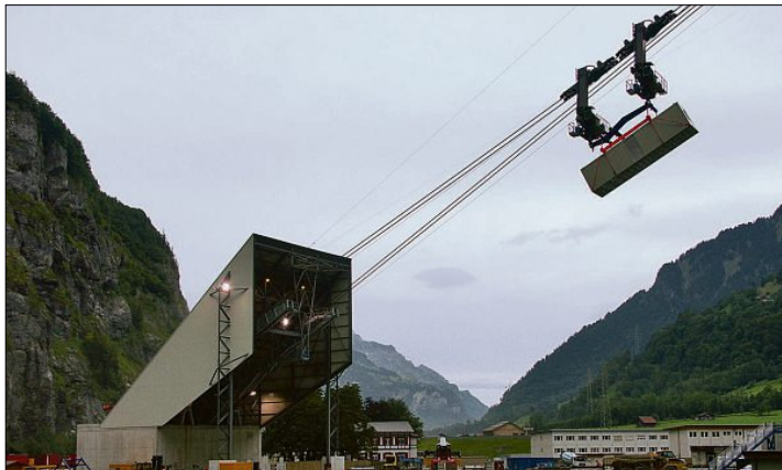
Containertransport mit der Seilbahn.
