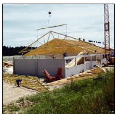
Bei Laumer Bautechnik aus Massing stammt alles aus einer Hand.
