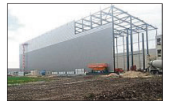
Die Halle während der Bauphase.
