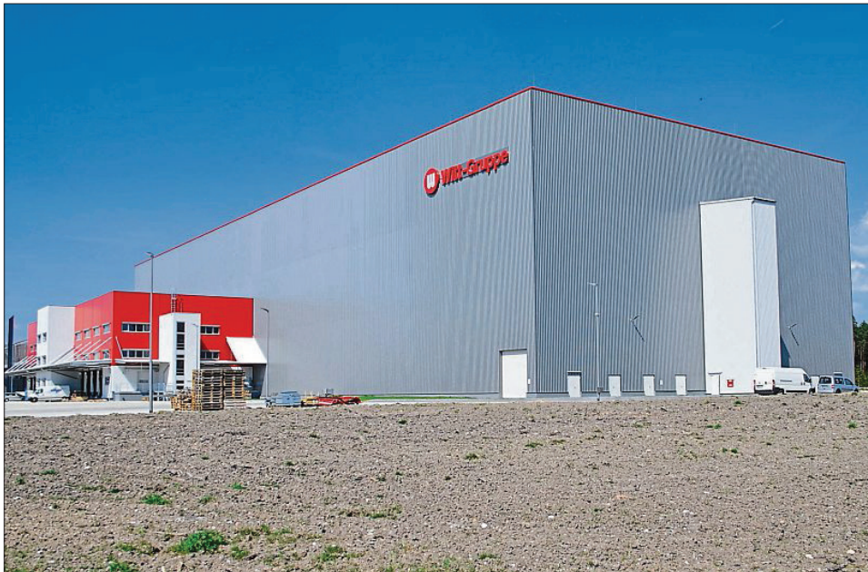
In dieser Halle befindet sich ein Hochregallager eines Textilversandunternehmens.
