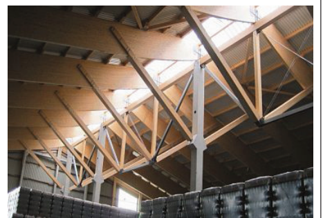
Glaswerke Großbreitenbach Neubau einer Halle
