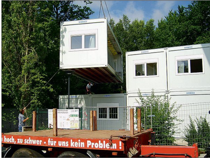
Mit Containern wurden für die Schule Vogelweh in Kaiserslautern flexible Raumlösungen geschaffen. Die Module gelangen komplett ausgestattet und anschlussfertig an ihren Einsatzort. FOTOS OECON
