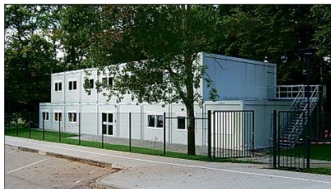
Mit Containern wurden für die Schule Vogelweh in Kaiserslautern flexible Raumlösungen geschaffen. Die Module gelangen komplett ausgestattet und anschlussfertig an ihren Einsatzort. FOTOS OECON
