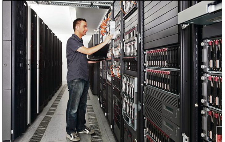
Mittels intelligenter Steuerung kann die Stromnetzauslastung reguliert werden.
