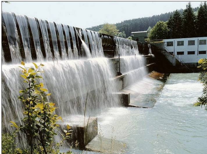
In Maria Steinbach (Landkreis Unterallgäu) befindet sich eines von drei Iller-Kraftwerken, die jährlich durchschnittlich 100 Millionen Kilowattstunden klimaneutrale Energie liefern. FOTO/LEW
