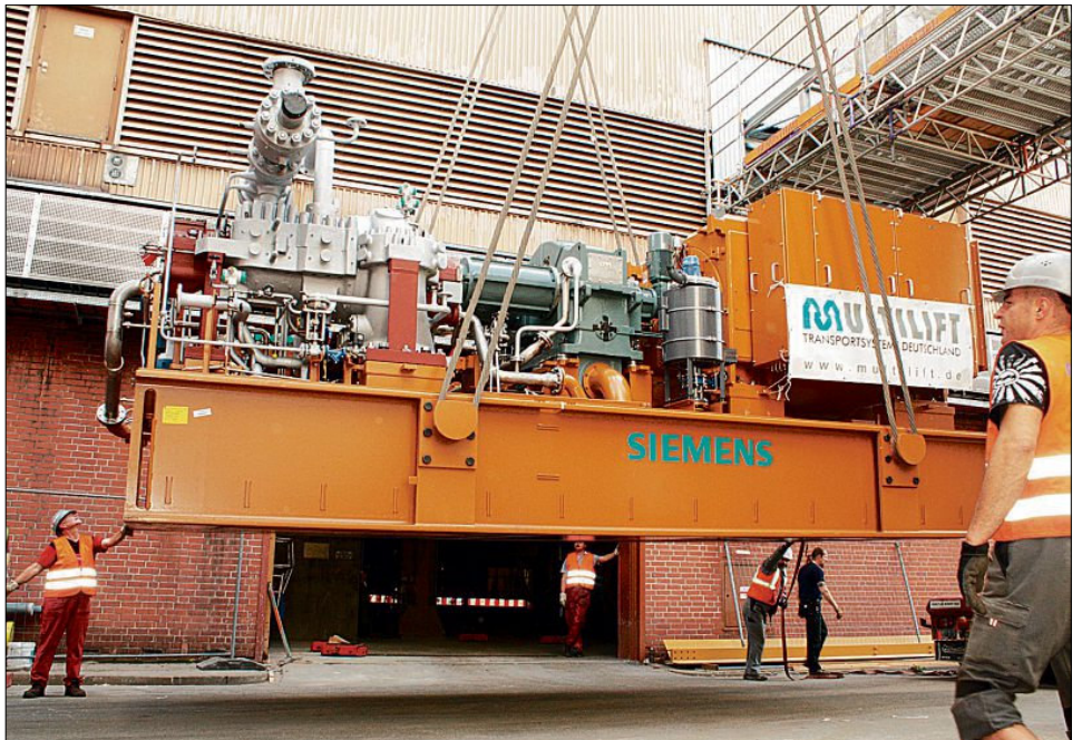
Der neue Dampfturbinensatz wird angeliefert.
