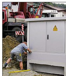
Alleine in Niederbayern müssen in diesem Jahr 500 neue Trafostationen errichtet werden. FOTO O&X
