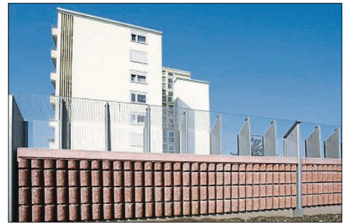
Lärmschutz mit Clearwall VS an der Wormser Nibelungenbrücke.
