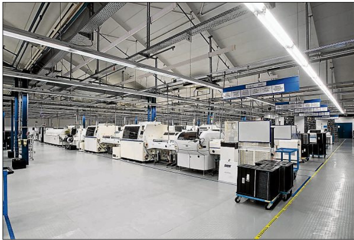
Die Lichtbänder des neuen Systems nutzen die vorhandenen Aufhängungsvorrichtungen, sind dabei aber um über 50 Prozent effizienter. FOTOS REGIOLUX/FRANK FREIHOFFER
