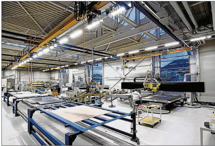
Anwendung der neuen Beleuchtung in einer Industriehalle.
