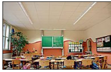
Cubus-Spiegelrasterleuchten mit elektronischen Vorschaltgeräten und Leuchtmitteln der EU-Effizienzklasse A sorgen in Kombination mit einer tageslichtabhängigen Beleuchtungssteuerung für optimales Licht.
