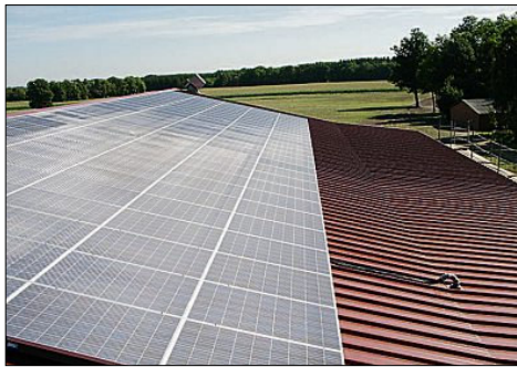
Photovoltaik ist ein Schwerpunkt der Renexpo.
