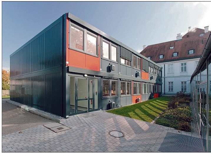
Die Fassade besteht aus Metallkassetten in gedecktem Anthrazit und leuchtendem Orange. FOTO B. STORZ
