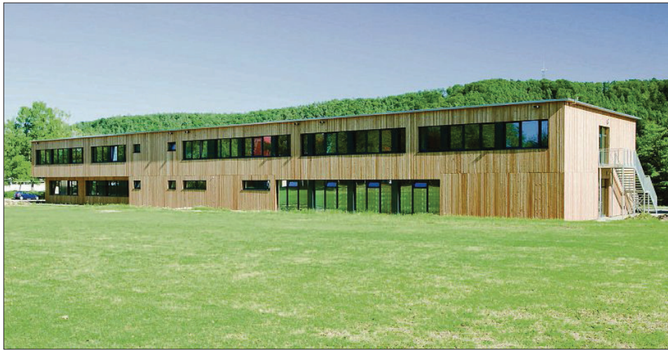
Der Neubau der Forstschule Rottenburg.
