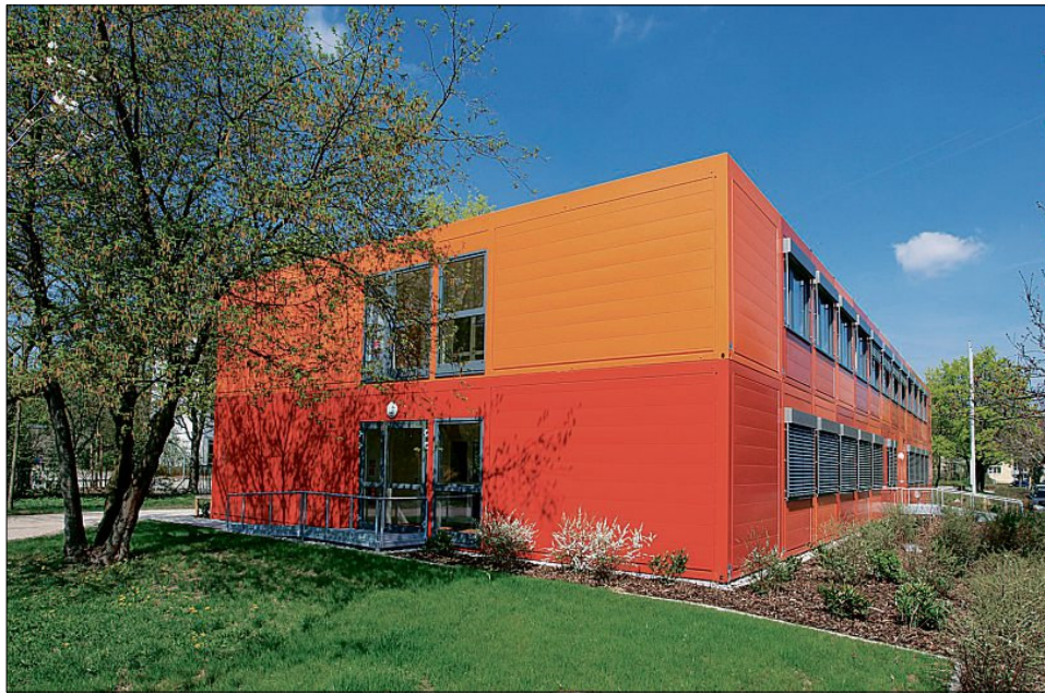
Das Interimsgebäude besteht aus orangefarbenen zweigeschossigen Raummodulen.
