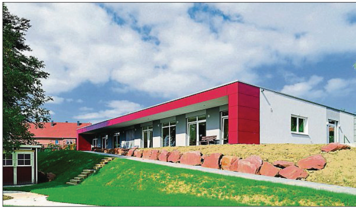
Blick in die Kindertagesstätte und der Neubau von außen.
