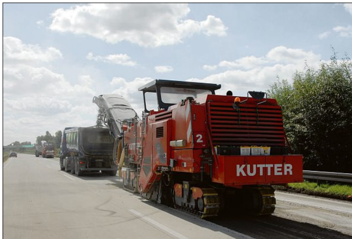
Die Betondecke wurde mit speziell modifizierten Hochleistungsfräsen in kleinstückiges Granulat verwandelt.
