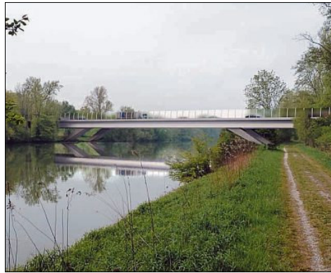
Der Siegerbeitrag (oben) der Ingenieurgruppe Bauen überzeugte das Preisgericht mit einem schlanken Brückenentwurf in Stahlbetonbauweise. Der mit dem 2. Preis ausgezeichnete Beitrag der SSF Ingenieure AG (links) sieht einen Verbundplattenbalken mit luftdicht verschweißten Hohlkästen aus WT-Stahl vor. Durch die Konstruktion des Überbaus als Stahlverbundträger über dem Flussfeld und als Spannbeton-Plattenbalken im Vorlandbereich nutzt der mit dem 3. Preis ausgezeichnete Beitrag des Ingenieurbüros Grassl die Vorteile beider Bauweisen.
